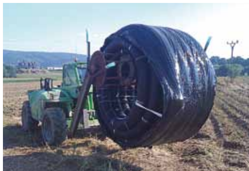
Die Rohre können direkt von der Rolle im Graben verlegt werden
