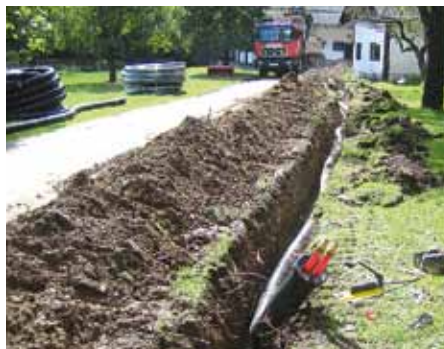
AUSTROFLEX Fernwärmerohre werden kanalfrei in der Erde verlegt
